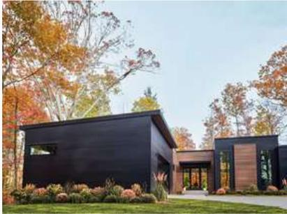
**Comercial Tecnoaislantes:** Distribuye Metal Siding la cual es fabricado por materiales sustentables, donde su estructura se encuentra compuesta por una superficie de Aluminio - Zinc, en su lado posterior tiene un recubrimiento de 100% aluminio y en su interior posee espuma de poliuretano.
